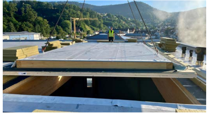
Aus logistischen Gründen musste die Abfüllanlage durch eine eigens entwickelte Holzbau-Luke im Dach eingehoben werden.
