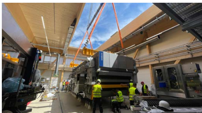
Ein Schwerlastkran für extremen Lasthub hat die Maschinenkomponenten durch die Luke eingehoben, wobei das schwerste Anlagenteil rund 35 Tonnen wog.
