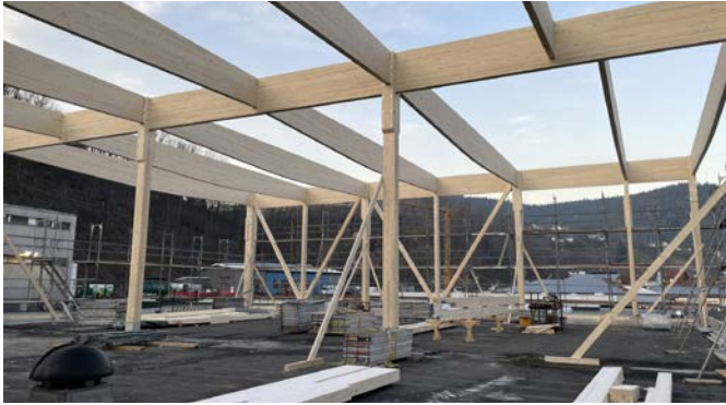
Das BSH-Tragwerk besteht im Wesentlichen aus Fischbauchbindern, Stützen, Abfangträgern sowie aus Pendel- und Giebelstützen.
