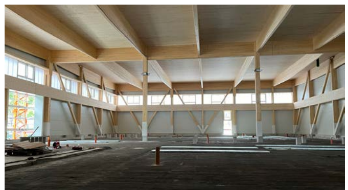
Die Gebäudehülle resultiert aus vorfertigten und zeitnah zu montierenden Sandwich-Elementen.
