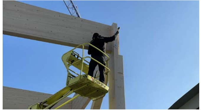
Die Abfangträger und Fischbauchbinder wurden in Gabellagerungen der Stützen eingelegt und mittels Schlitzblechen und Stabdübeln angeschlossen.
