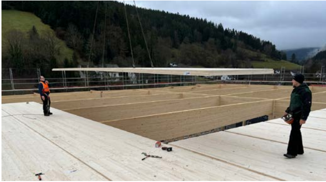
Die Dachscheibe aus Brettsperrholz steift die Gesamtkonstruktion aus.
