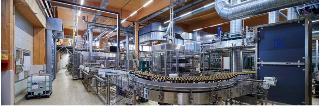
Für die traditionsreiche Alpirsbacher Brauerei hat mit der Inbetriebnahme der vollautomatischen Abfüllanlage ein neues Zeitalter begonnen.
