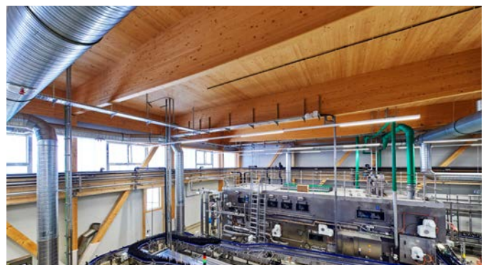
Die massivhölzerne Dachscheibe fungiert auch als feuerhemmender Raumabschluss.
