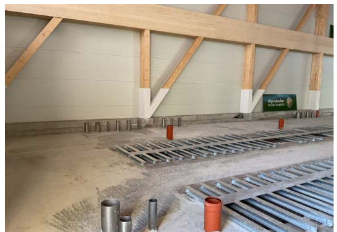
Zwecks Aufnahme der Sonderlasten einzelner Maschinentteile mussten Stahlpodeste aufgebaut werden, während die Fußpunkte des BSH-Tragwerks gegen Nässe eingehaust wurden.
