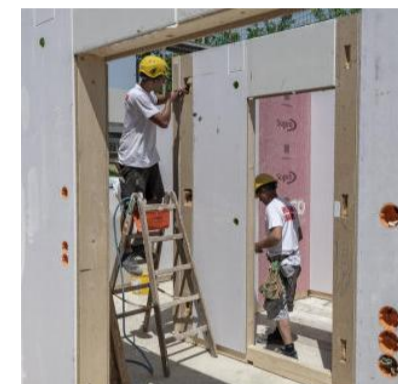
Holzhäuser haben spezielle Brandschutzanforderungen. FOTO: DPA-THEMEDIENST/DANIEL MAURER
