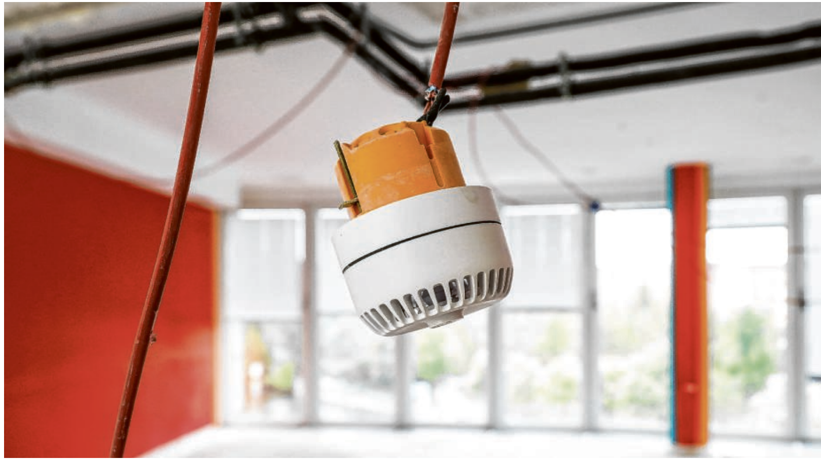
Durch Brandsimulationen lässt sich vor der Installation von Rauchmeldern ermitteln, ob sich ihre nach DIN-Normen geforderte Zahl reduzieren lässt, ohne die Sicherheit in einem Gebäude zu schmälern. Für die Bauherren lassen sich so Kosten beim Bau und beim Gebäudeunterhalt senken. FOTOS: IMAGOJOCHEN ECKEL / PORTRÄT: ANDREA FOTOGRAFIE & DESIGN
