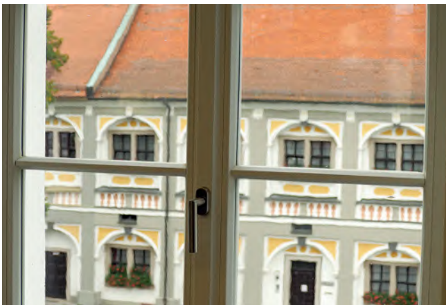
Rathaus Waldsassen: Blick durch ein Isolierglasfenster mit mundgeblasenem Glas.
