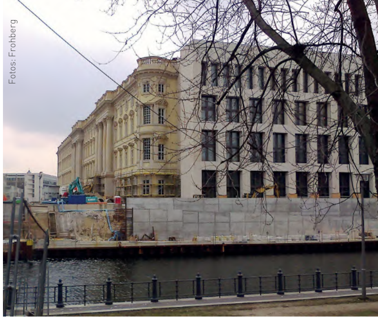
Humboldtforum Berlin: Übergang von Rekonstruktion und Neubau.
