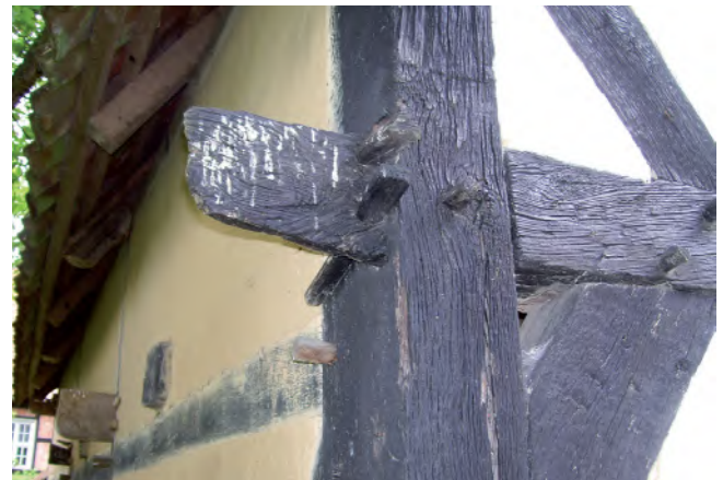
Der durchgeschossene Zapfen ist namensgebend für das „Geschoss“ als Begriff für Etage.
