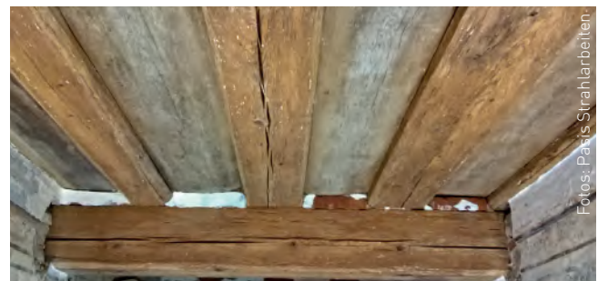
Eine sandgestrahlte Holzbalkendecke nach mehreren Arbeitsgängen.
