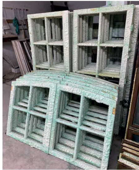
Ausgebaute Fensterflügel, Entlackung der Fensterflügel in der Fachwerkstatt und eingepastete Fensterflügel.
