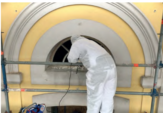
Sanierung der Fenster von außen vom Gerüst.
