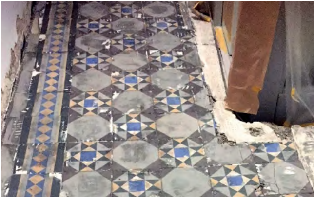
Der beschädigte Originalfußboden und das Ergebnis nach der Sanierung.
