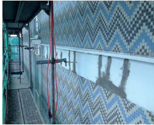
Sanierungsarbeiten am Mosaik des Kölner Haus Buch.
