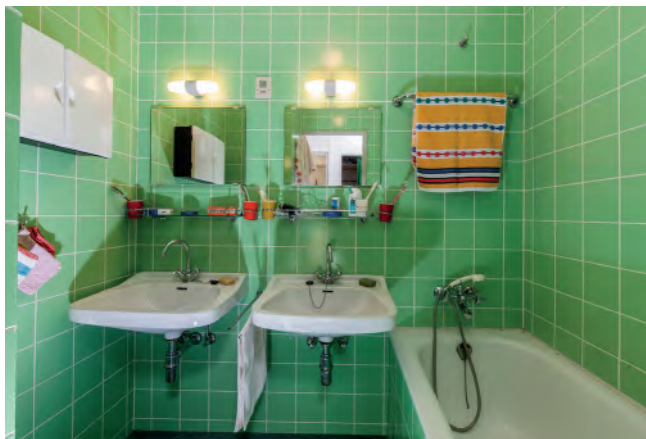
Freigelegte und restaurierte Wandfliesen im Bad.
