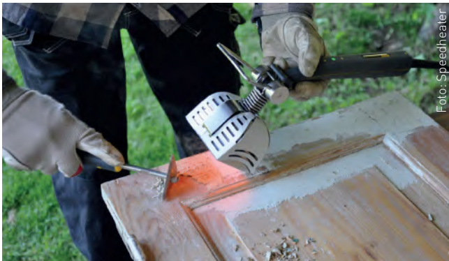
Die thermisch-mechanische Reinigung bietet sich bei der Entfernung alter Farbschichten auf überschaubaren Flächen an.
