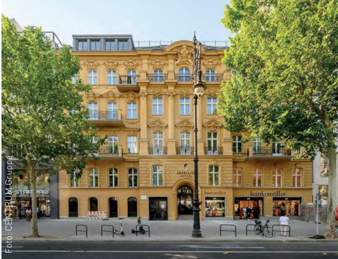
Das Gründerzeithaus am Kurfürstendamm 15 wurde als weltweit erstes denkmalgeschütztes Gebäude mit DGNB-Platin zertifiziert.
