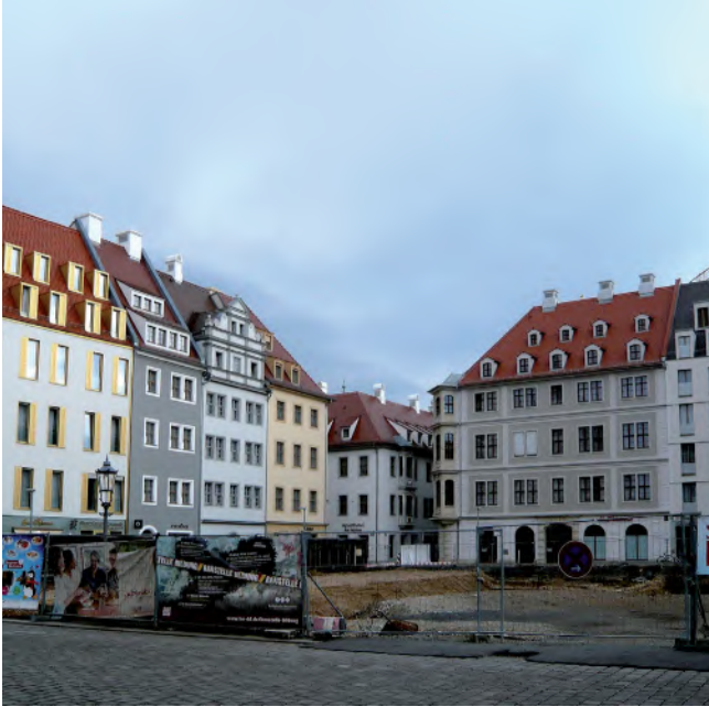
Rekonstruktion und Neubau am Dresdner Stadtschloss.
