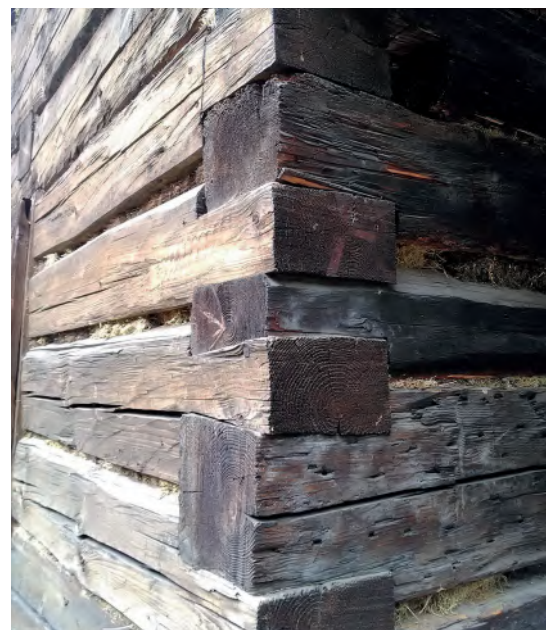
Blockbau mit ausgestopften Fugen.
