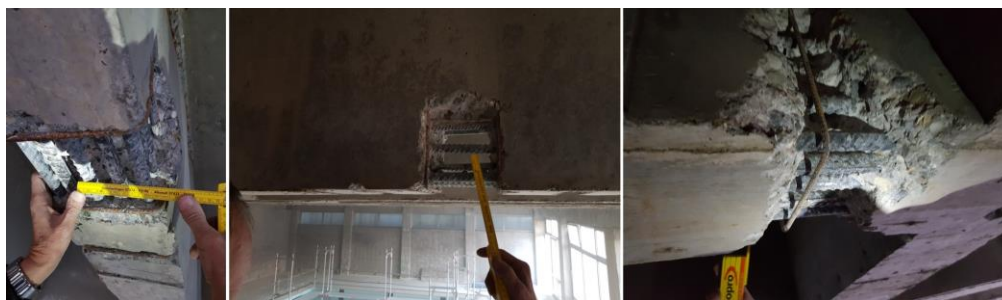
Abbildung 4 | Exemplarische Bilder der Beprobung der Unterzüge (Stahlbeton-Rippendecke)
