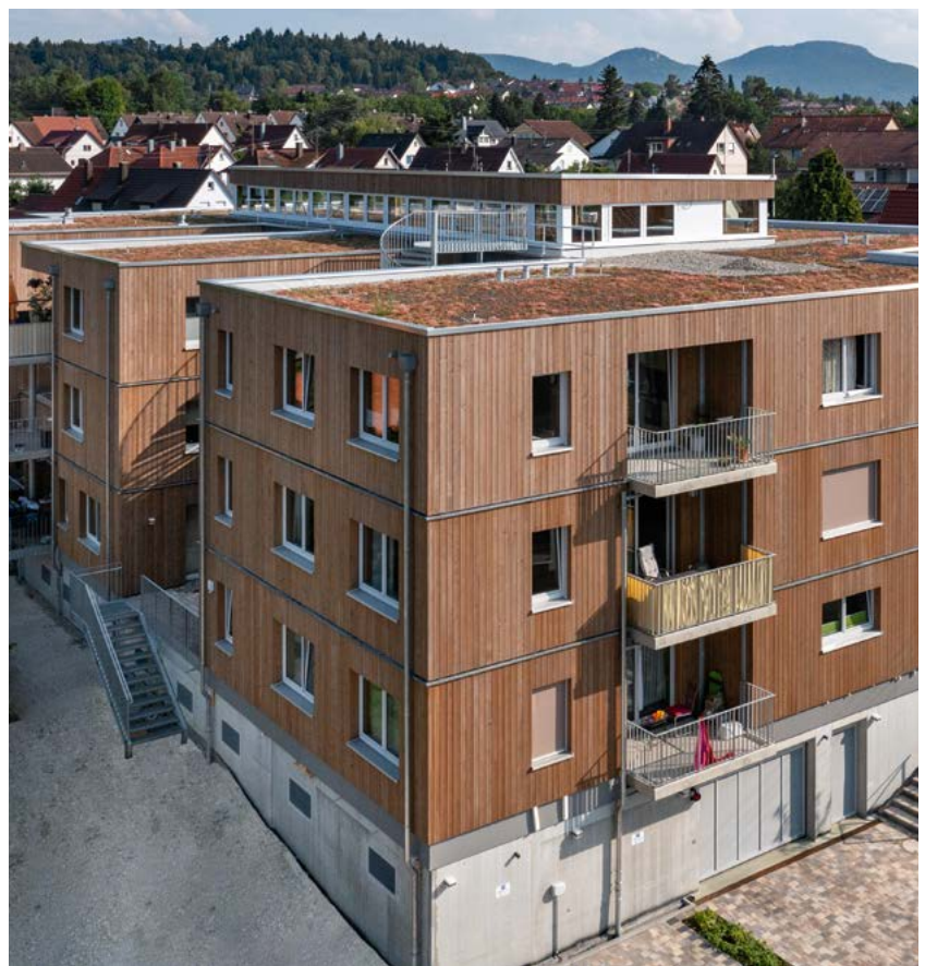
Das Wohnhaus in Balingen zeigt Brandschutz im Holzbau der Gebäudeklasse 4 mit sichtbaren Holzoberflächen. Foto: Martin Duckek Fotografie, Ulm
