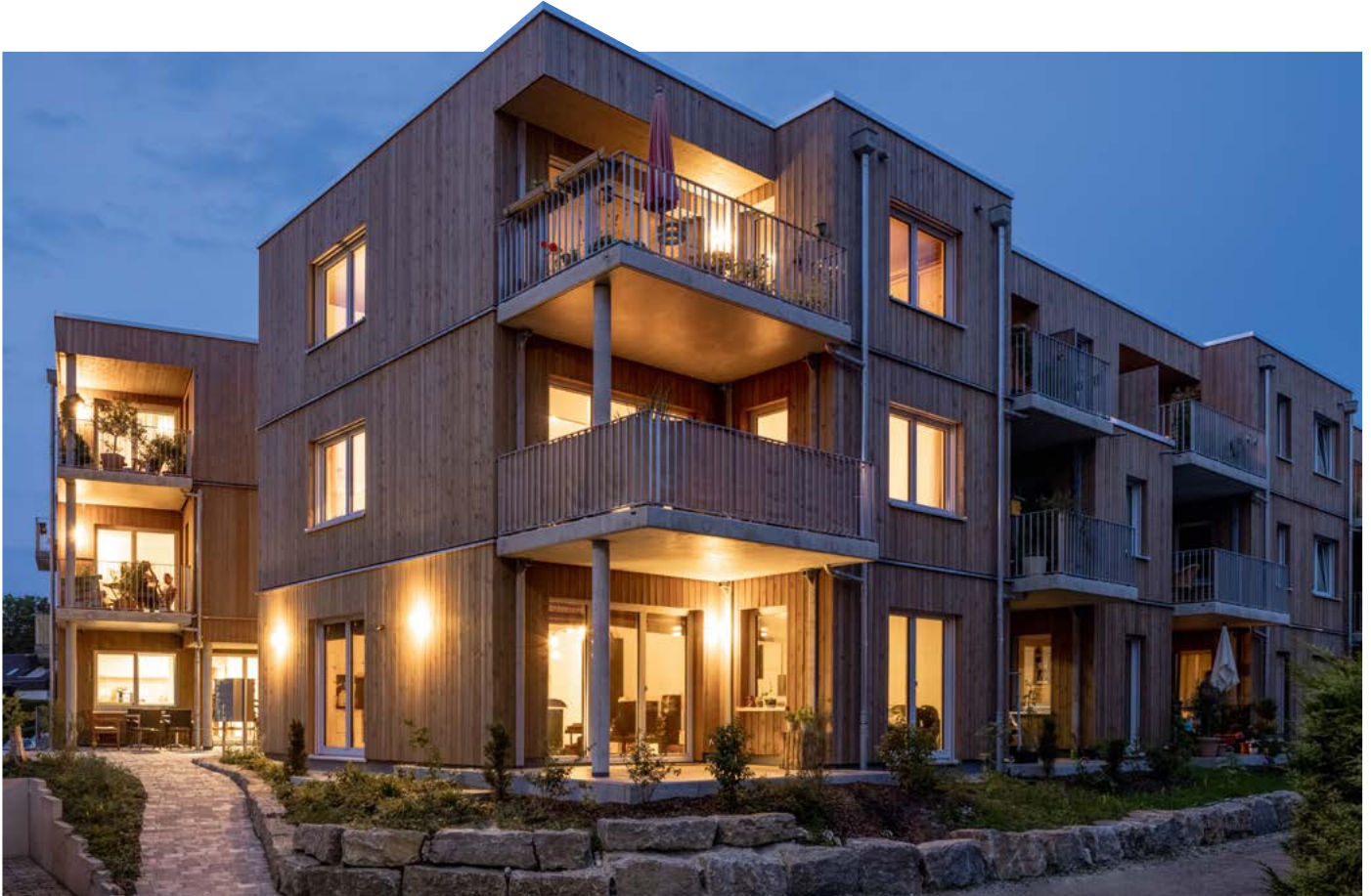
Neubau eines gemeinschaftlichen Mehrgenerationen-Wohnprojekts in Holzmodulbauweise. Foto: Martin Duckek Fotografie, Ulm
